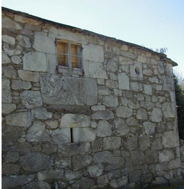
Distintas fábricas: mampostería e perpiaño (arriba) e cantaría (abaixo)
